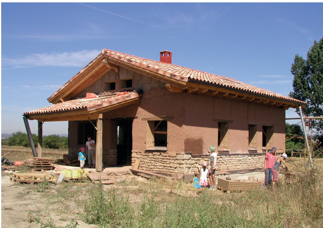
Goiko irudian ~ Egileak: Nagore Tolosa eta Ekaitz Uribe. ~ Autoeraikitako etxe baten lanak
